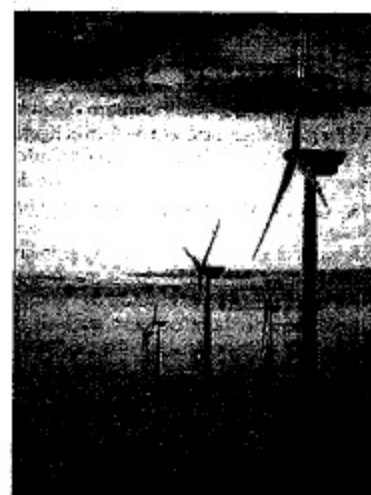
Instalación eólica marina.
